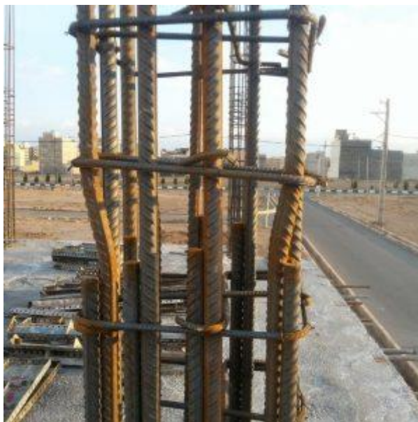
شکل ۷: وصله آرماتورهای ستون
