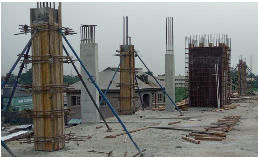
شکل ۲: اجرای ستون بتنی
