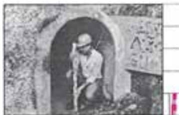
شکل ۱۴-۸ — طریقه‌ی نگاه داشتن میر
