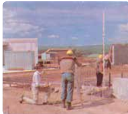
شکل ۱۴-۸ — طریقه‌ی نگاه داشتن میر
