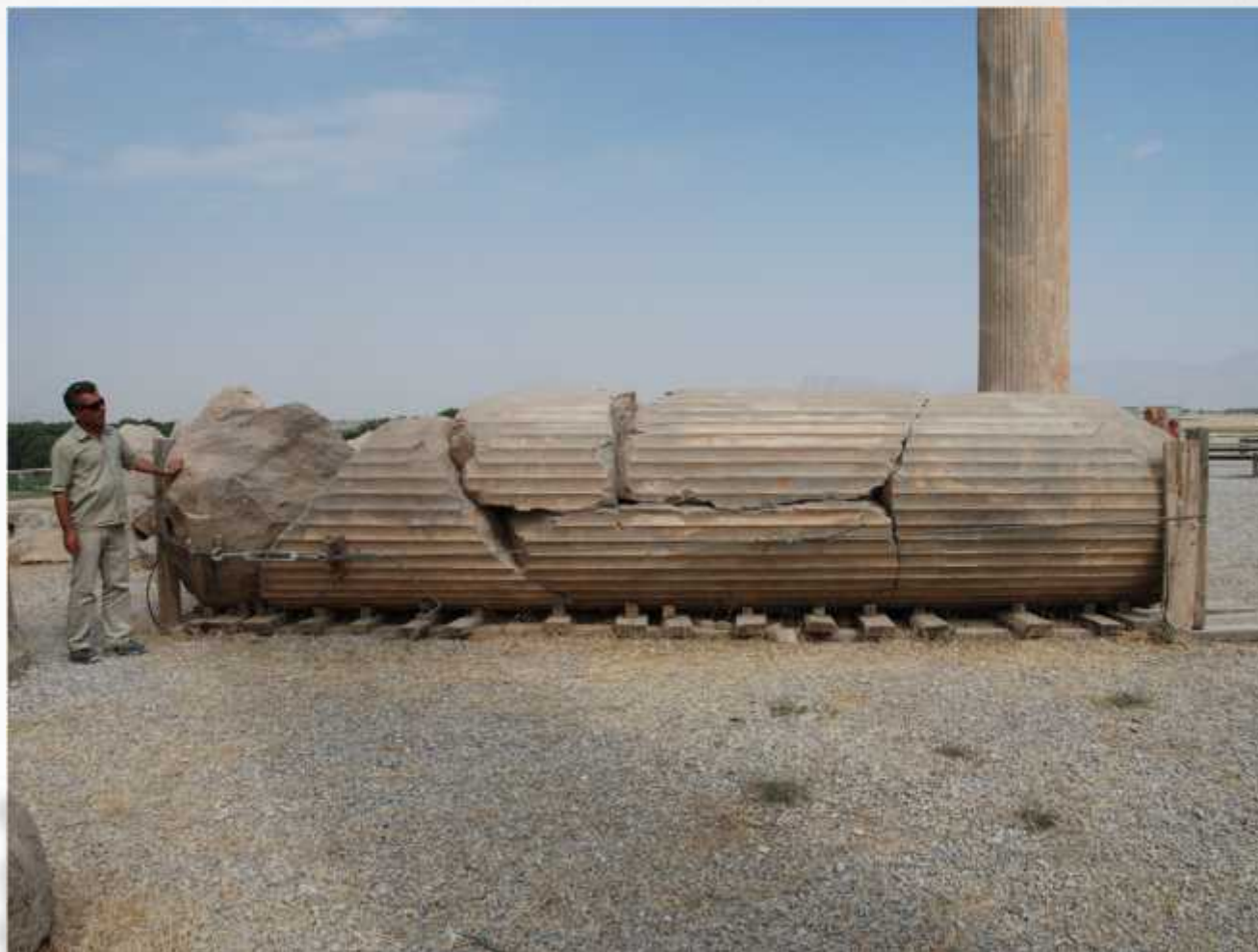
مرمت بخشی از یک ستون به شیوه ای ساده و نگرشی نو
