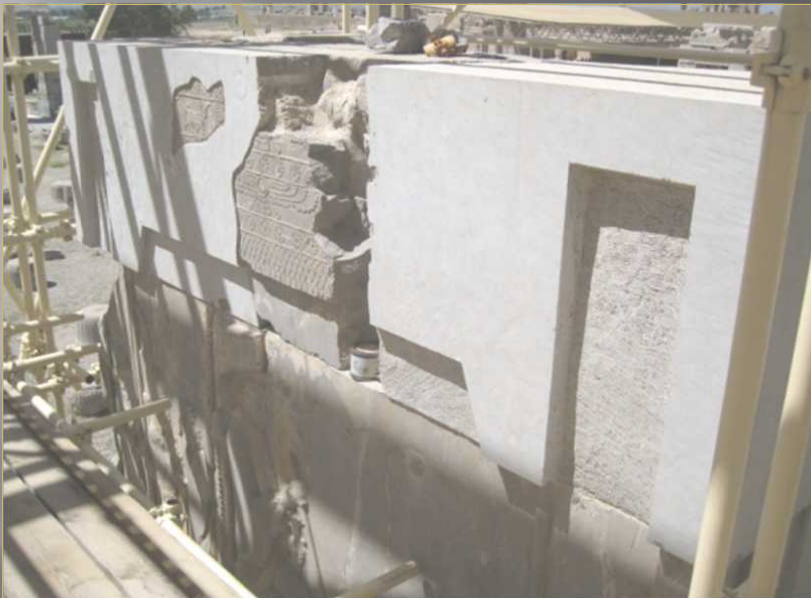
ردیف هشتم جزر غربي درگاه شمالی ضلع شرقی صدستون قسمتهای زیادی با سنگ جدید بازسازی شده است ولی بخشهایی از سنگ جدید نیاز به بار ریزی و هاشور زنی دارد.
