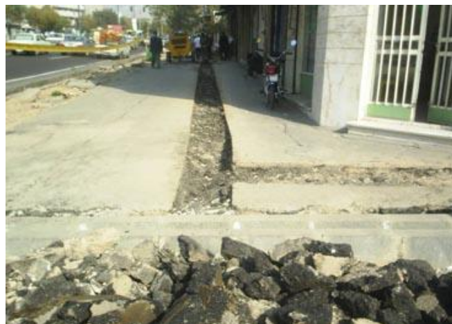
17- نصب موانع فیزیکی جهت جلوگیری از ورود موتورسیکلت
