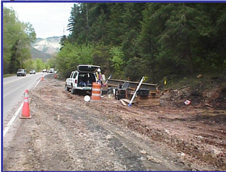
3000 ton O-cell Test
