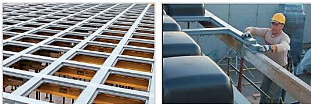
شکل ۸. قالب بندی و کفراژ بندی
