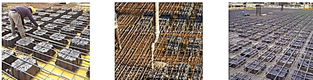
شکل ۱۶. مراحل د تا و اجرای سقف یوبوت
