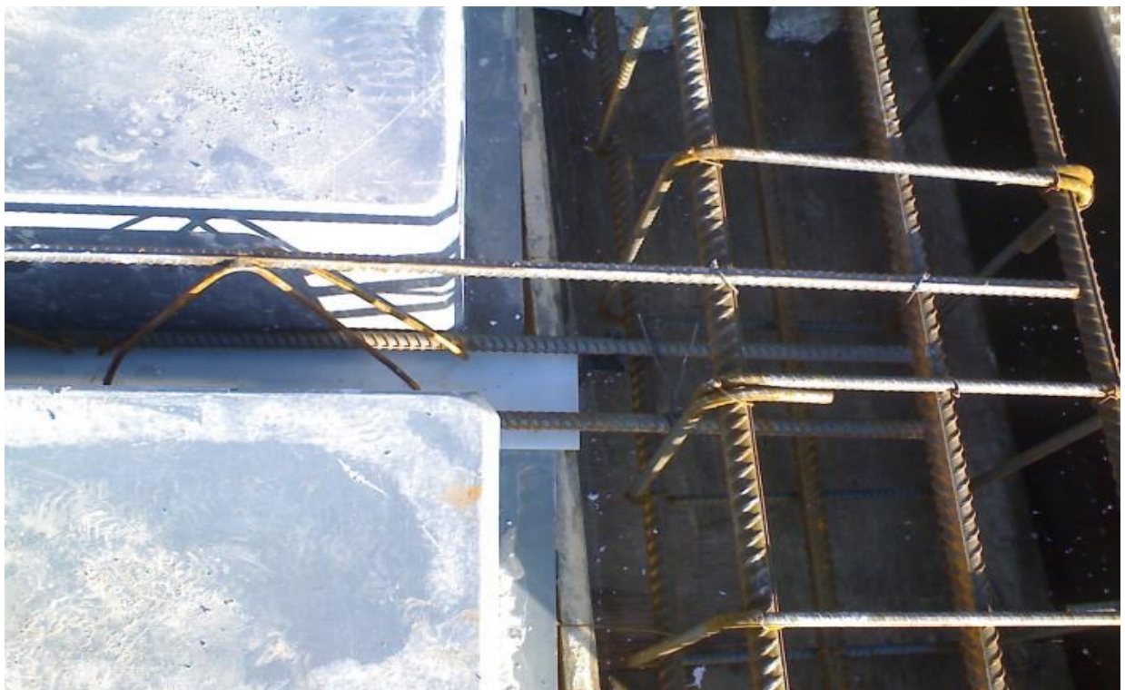
عدم نیاز به جابجایی خاموت ها هنگام اجرای تیرچه درجا
