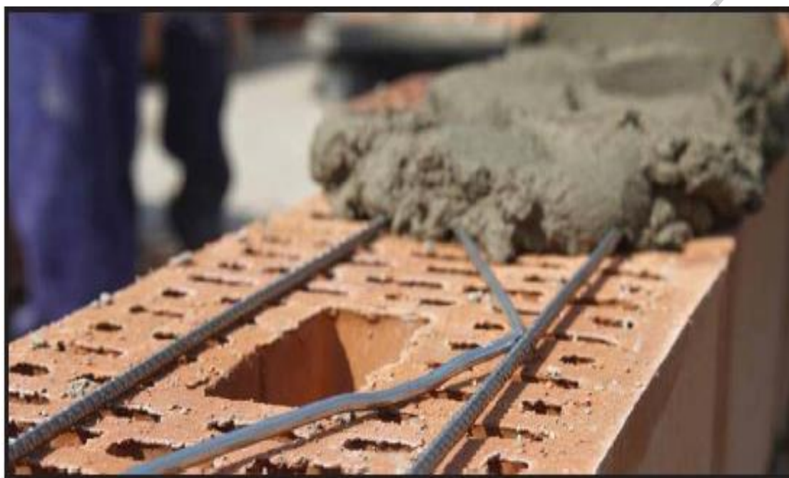
شکل ۱۰-میلگرد بستر خربایی قبل از پخش ملات بستر
